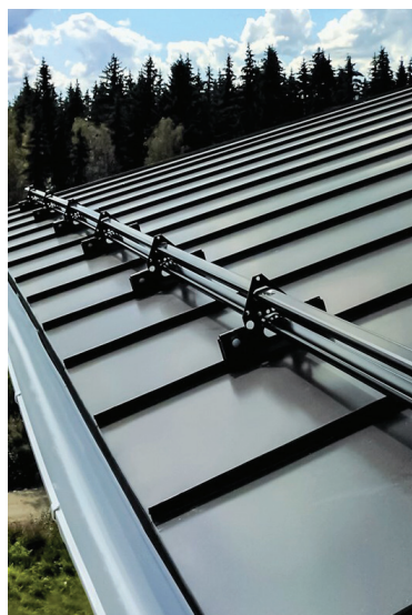
Lumetöke on vältimatu katusele kukkuvat lume ja jää eest kaitsmisel.
